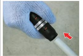
継手の保護シールを剥がしてください。管の全周が面取りできていることを、再度確認し、まっすぐ奥まで挿入してください。
