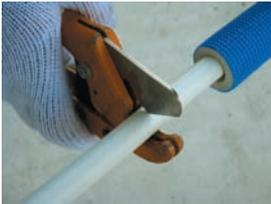
パイプカッターを使用し、直角に切断してください。
