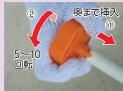
管を奥まで確実に差し込み、5~10回転させてください。面取り幅約2mm
