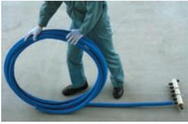
管・保温材の内外面にキズ・異物がつかないように平滑な所で、転がしながら巻きぐせを修正してください。管が短い場合には、専用インナーベンダーを使用することで容易に修正できます。
