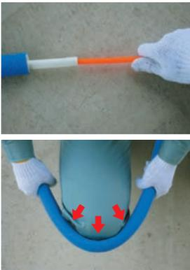
管の曲げ加工を行う際は、必ず専用のインナーベンダーを使用し、最小曲げ半径より大きく曲げてください。曲げ加工部の両端を持ち、曲げ加工を行う位置にひざを当てて少しずつ位置をずらしながら形状を作ってください。
