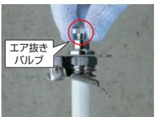
③ エア抜きバルブを緩めて十分にエアを抜いてください。エア抜きバルブより水が噴出されることを確認後、エア抜きバルブを締め付けてテスト圧力を徐々にかけてください。
