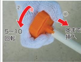
専用の面取り矯正器を使用し、管を奥まで確実に押し込み、5~10回転させてください。
