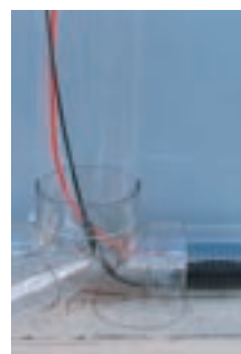
パッカーによる補修
