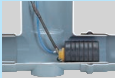
止水プラグによる補修
