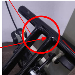
クロスバー上部
