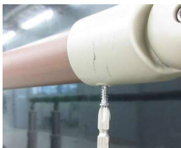
6. 新しいねじを使用して電動ドリルドライバーで締結してください。
