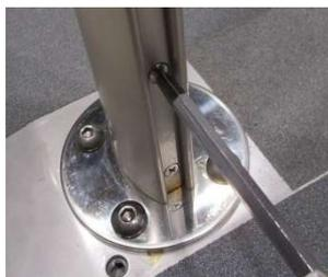
2. 支柱プレートカバーを外すと、支柱と固定プレートを接続しているボルト6箇所をプラスドライバーで外し、外支柱を上を抜いてください。※硬い場合、電動ドリルドライバーで外してください。
