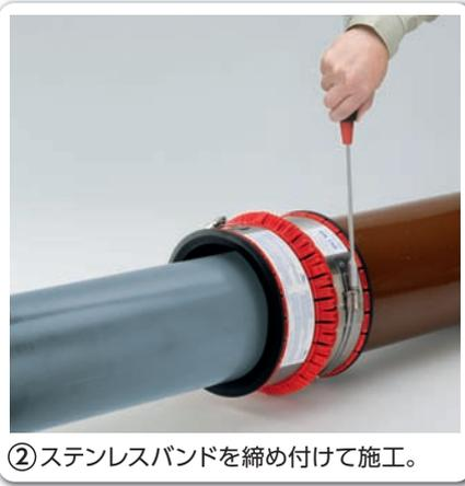
② ステンレスバンドを締め付けて施工。
