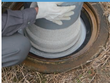
補修用立管挿入
