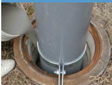
無収縮急結モルタル充填
