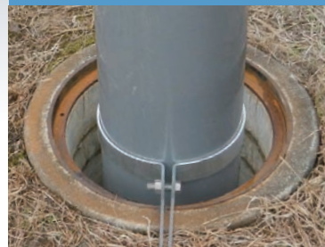
補修用立管仮固定
