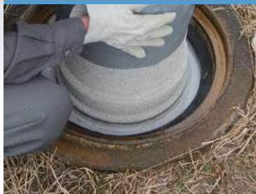
補修用立管挿入
