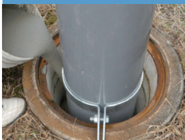
無収縮急結モルタル充填
