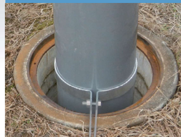
補修用立管仮固定
